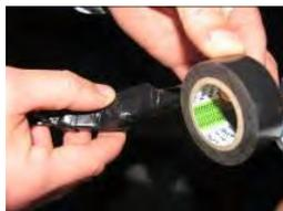
(NL) Sluit de stekker aan op het stopcontact van de hardtop. Breng isolatietape aan rond de verbinding (bescherming tegen vocht).
